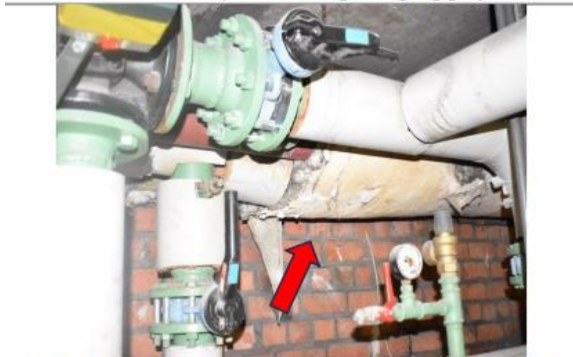
ZW-2023-2224-A-2, buisisolatie mengstaal stooklokaal links
