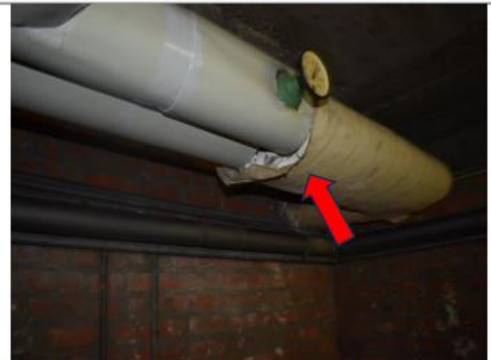
ZW-2023-2224-A-2 buisisolatie mengstaal stooklokaal links
