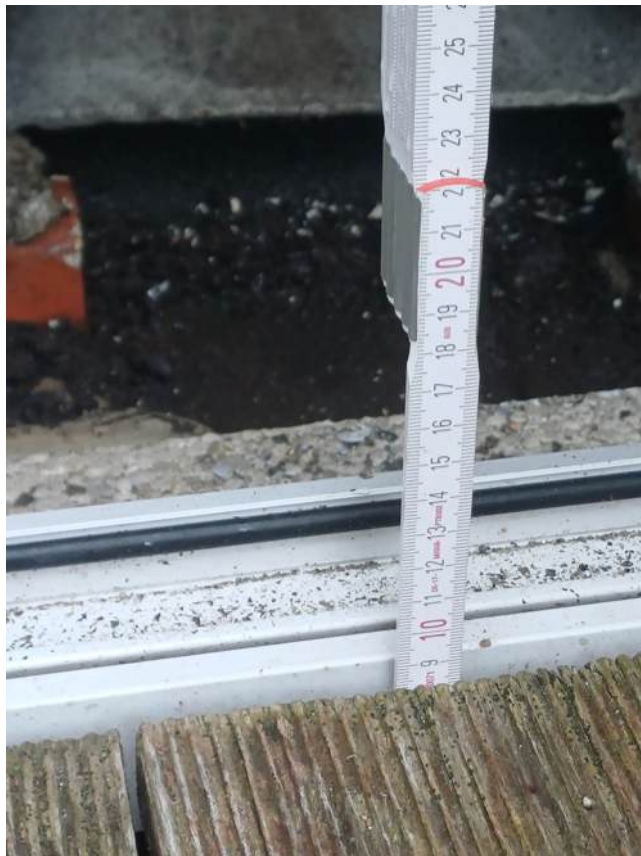
dakterras landzijde oost - 20260210_120244.jpg
