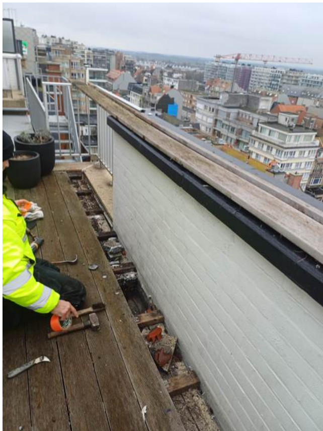
dakterras landzijde west - 20260210_122254.jpg
