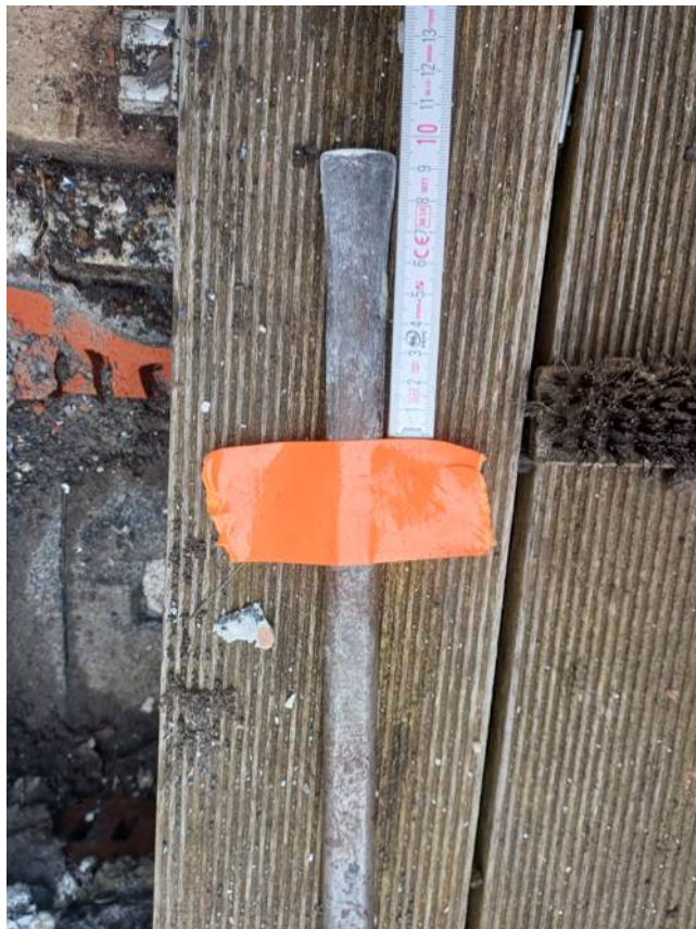
dakterras landzijde west - 20260210_122314.jpg
