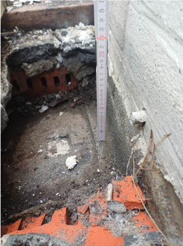
dakterras landzijde west - 20260210_122347.jpg
