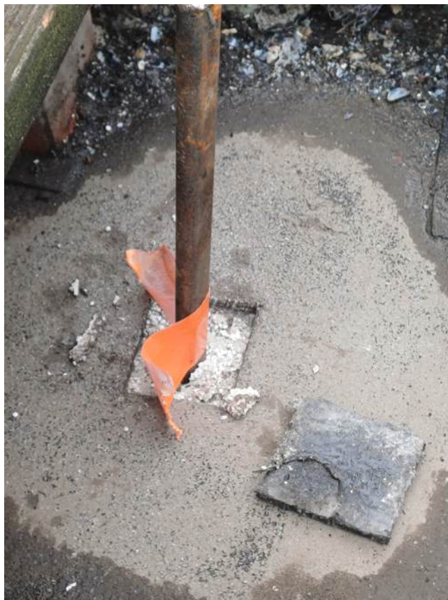
dakterras zeezijde - 20260210_113259.jpg
