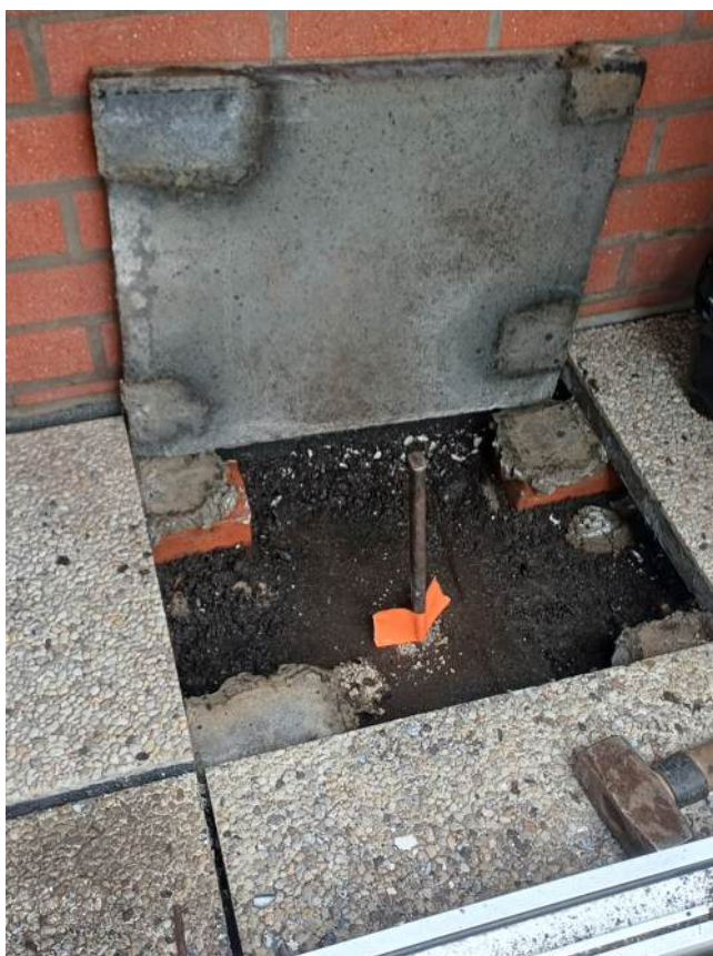
dakterras landzijde oost - 20260210_120207.jpg
