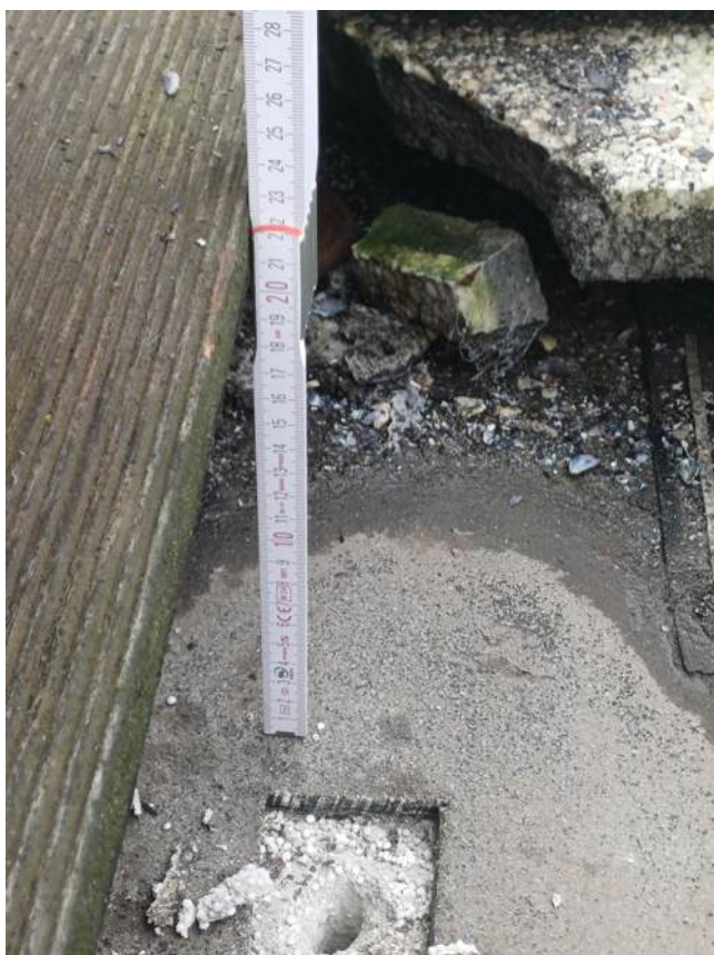
dakterras zeezijde - 20260210_113353.jpg
