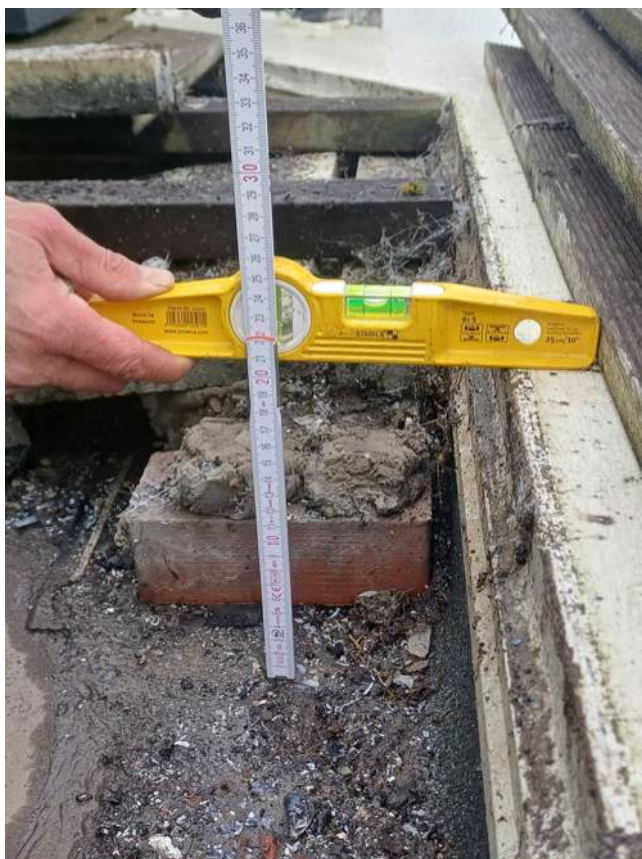
dakterras zeezijde - 20260210_113426.jpg
