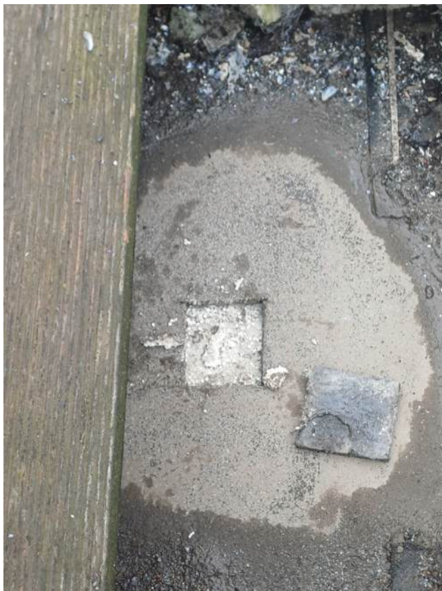
dakterras zeezijde - 20260210_113219.jpg
