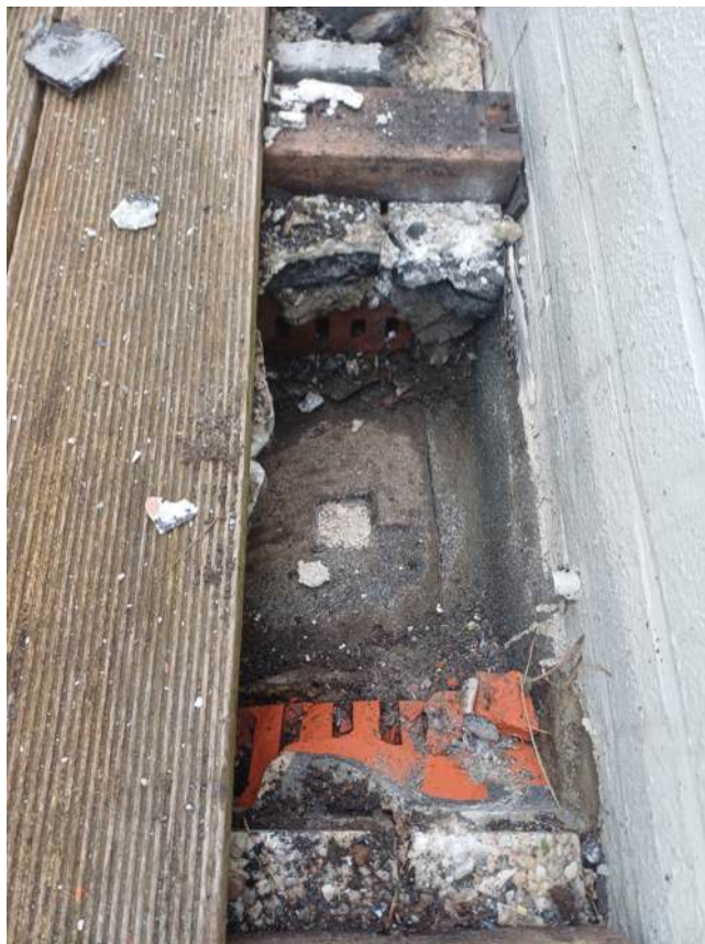
dakterras landzijde west - 20260210_122237.jpg
