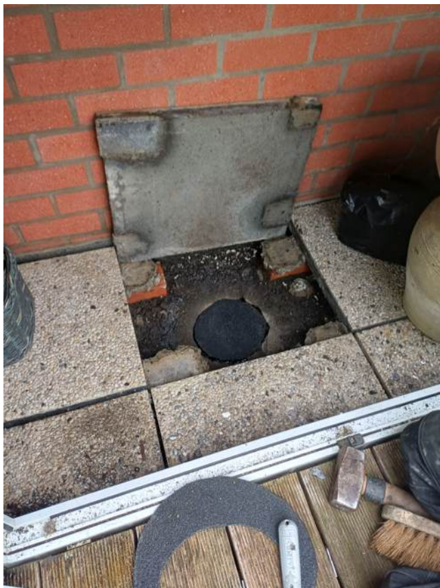
dakterras landzijde oost - 20260210_120748.jpg
