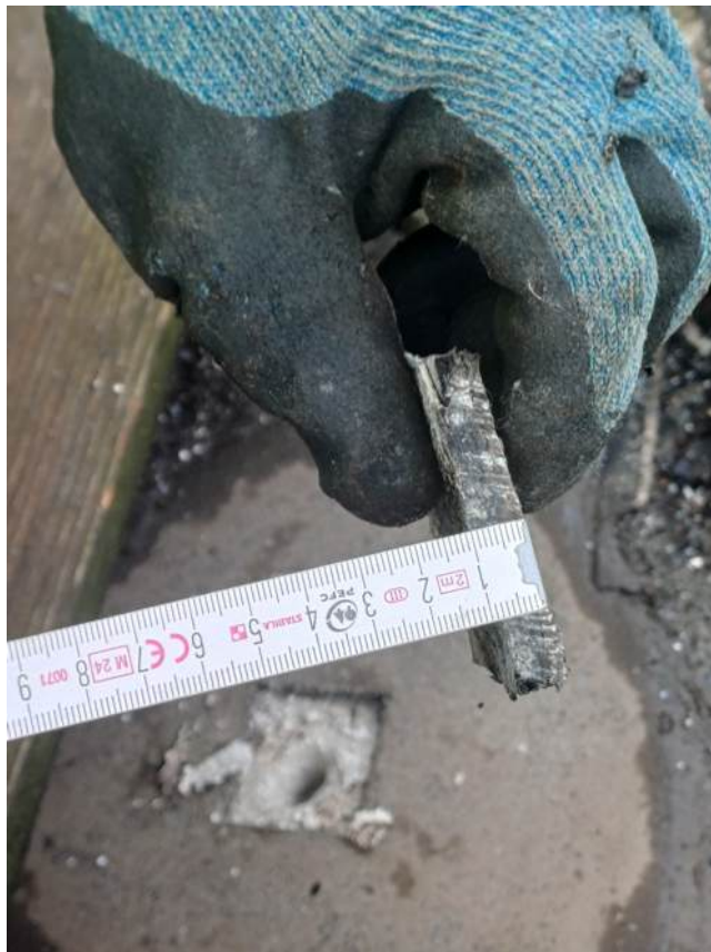
dakterras zeezijde - 20260210_113346.jpg
