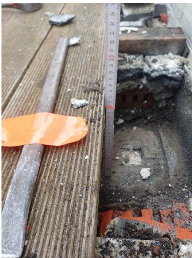
dakterras landzijde west - 20260210_122325.jpg
