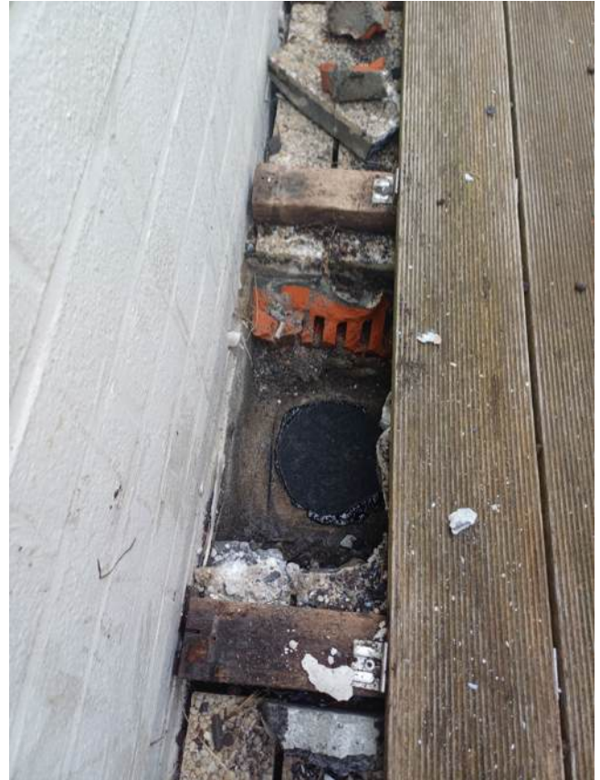
dakterras landzijde west - 20260210_122715.jpg
