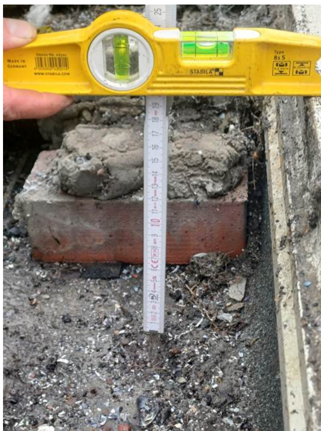
dakterras zeezijde - 20260210_113408.jpg
