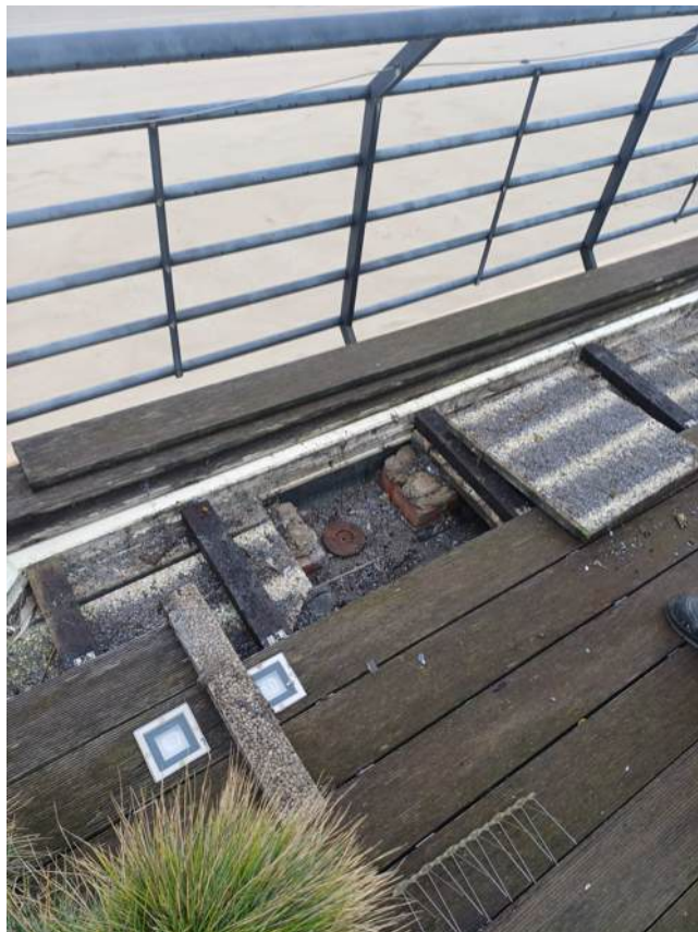
dakterras zeezijde - 20260210_112800.jpg
