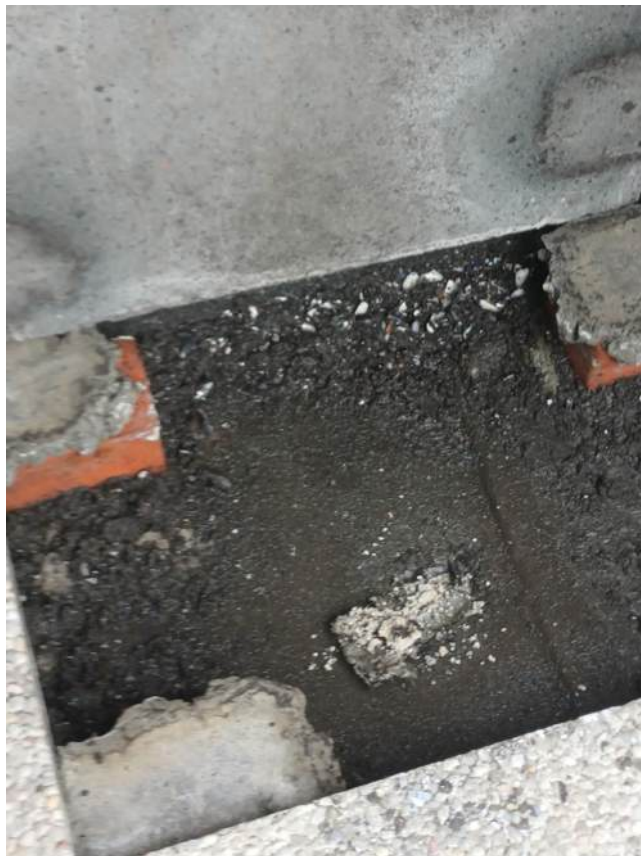
dakterras landzijde oost - 20260210_120132.jpg
