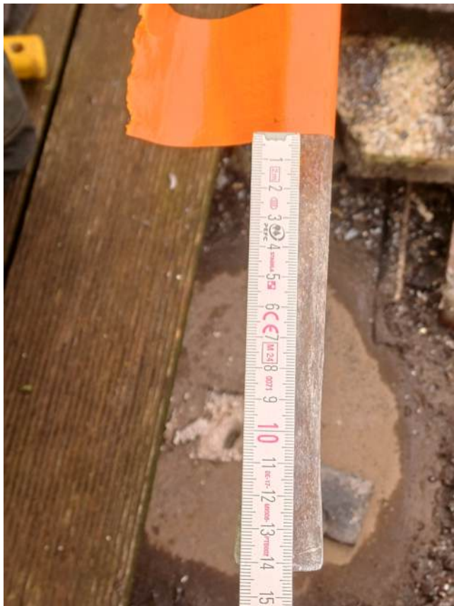
dakterras zeezijde - 20260210_113316.jpg
