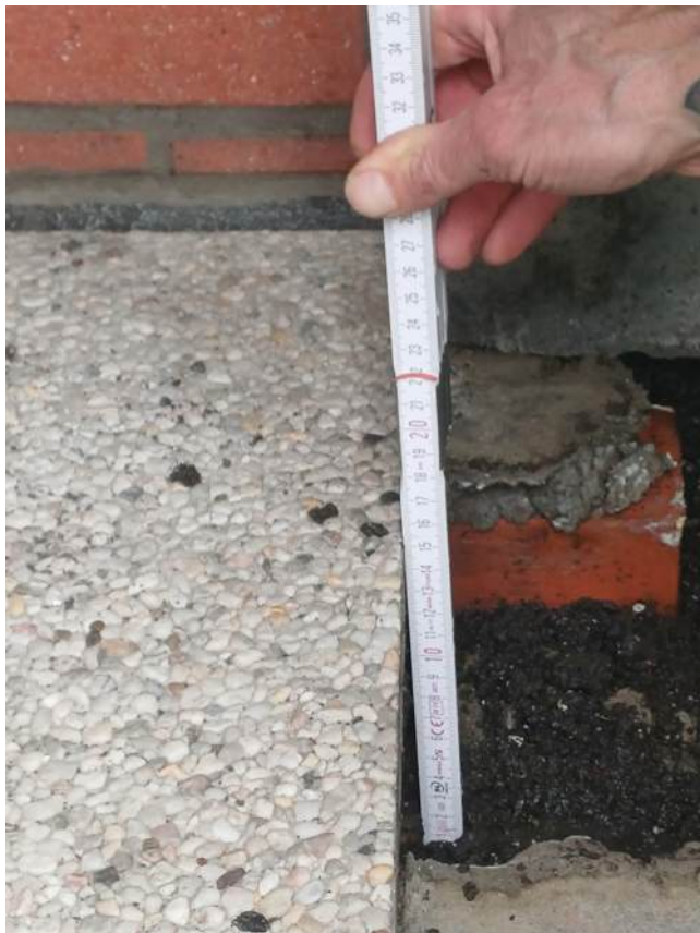
dakterras landzijde oost - 20260210_120237.jpg
