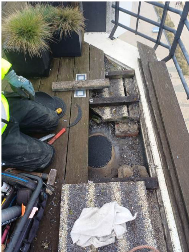
dakterras zeezijde - 20260210_113708.jpg
