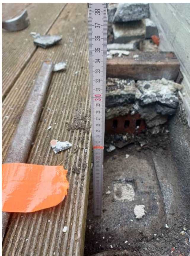
dakterras landzijde west - 20260210_122327.jpg
