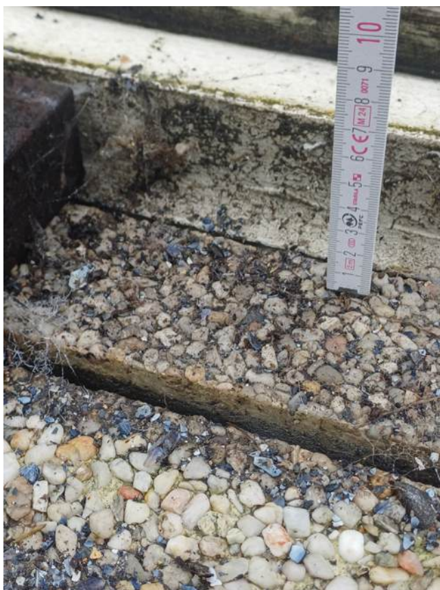
dakterras zeezijde - 20260210_113452.jpg
