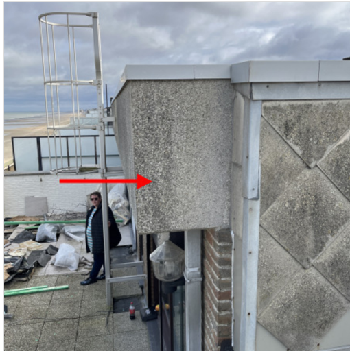
randaansluiting voorgevel en blinde zijgevel
