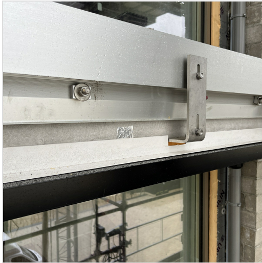
proefopstelling profielen ontwatering sokkelprofiel balustrade
