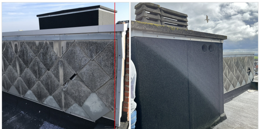
randaansluitingen onafhankelijk maken van achtergevel schouw buurgebouw
