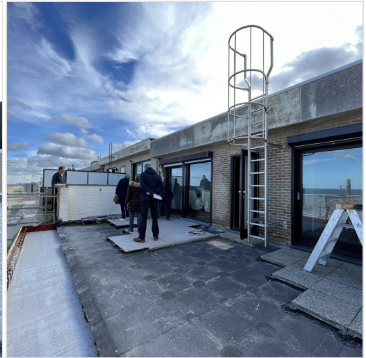
eindscherm kant middelkerke (3,80 m lengte en 60 cm hoogte)
