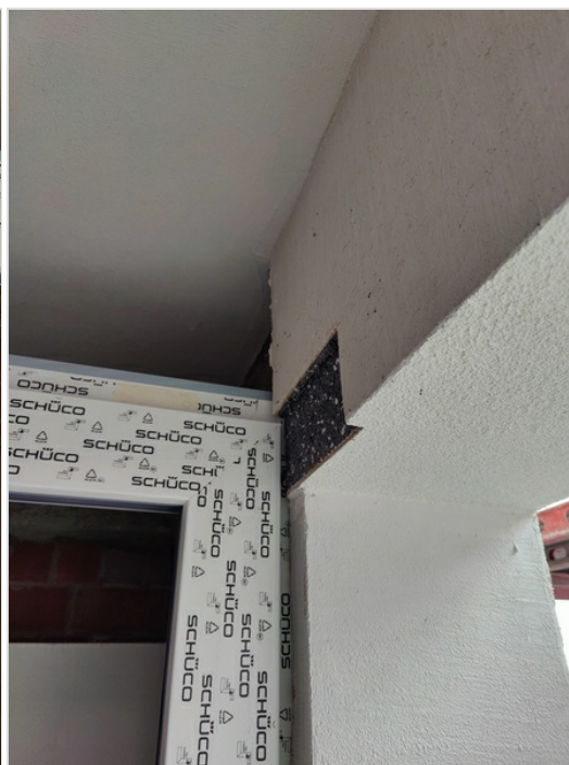
Strook verwijderd en opnieuw afgewerkt in crepi
