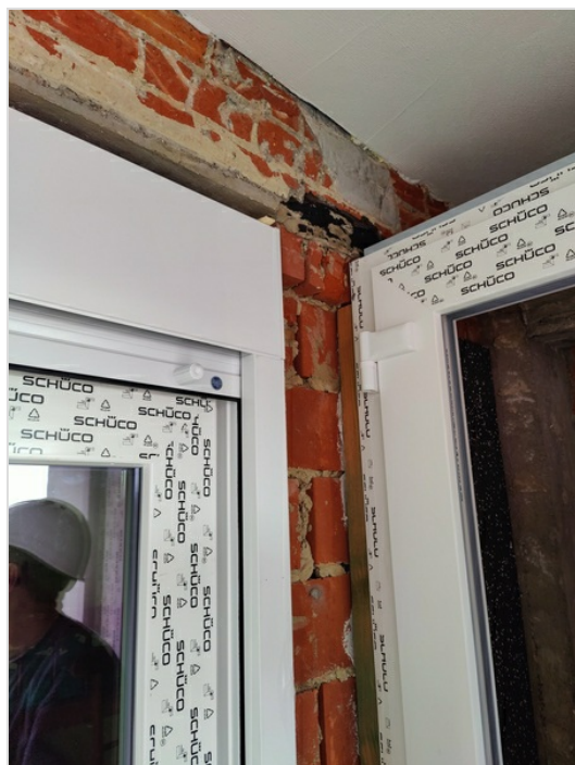
Verspronging aangehouden thv balk
